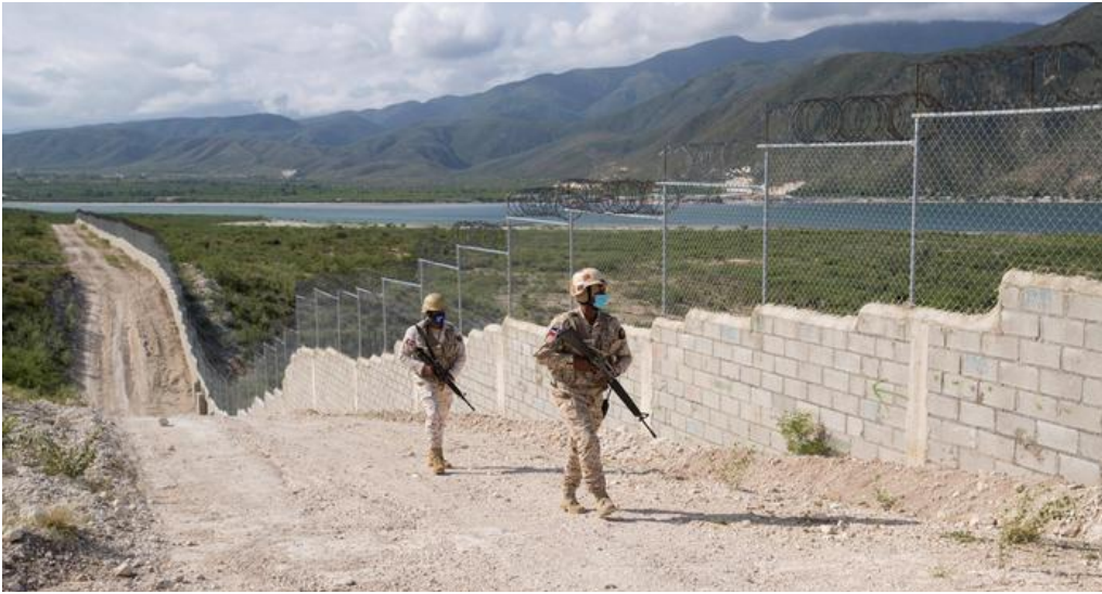
Verja perimetral construida por el gobierno y autoridades militares. Esta verja ha contribuido mucho a la reducción del contrabando e infracciones ambientales.
