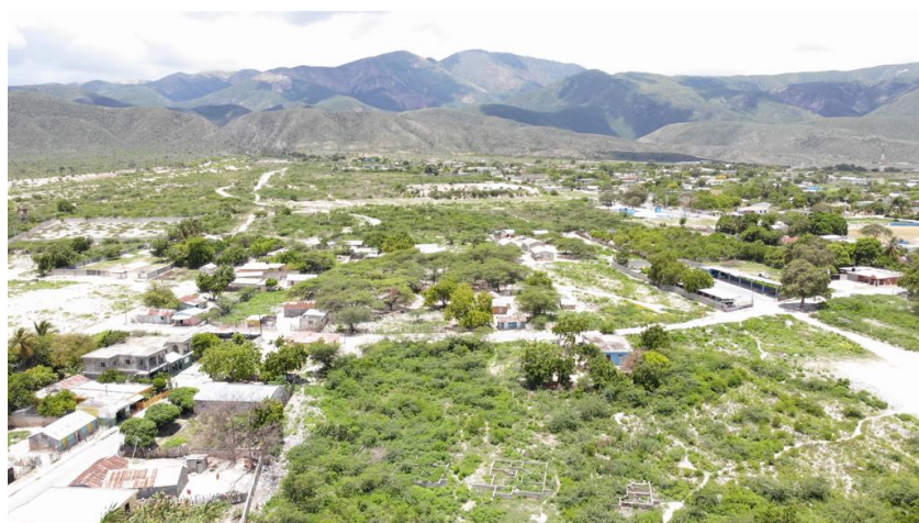
Fotos: Unidad de Drones CESFronT. Antigua comunidad La Cuarenta (lado dominicano). Este fue un barrio diseñado por el gobierno, que tuvo que ser abandonado debido a las riadas del Río Blanco en el 2004. Actualmente, las viviendas deterioradas y abandonadas están siendo ocupadas por ciudadanos haitianos.
