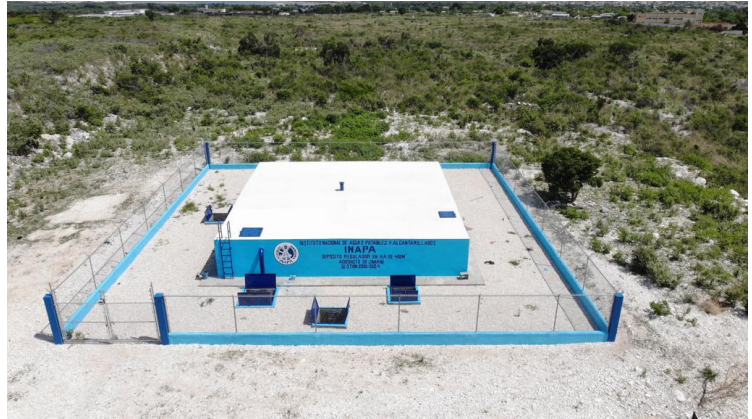
Foto: Unidad de drones del CESFront. Vista del nuevo acueducto de Jimaní, construido por el Instituto de Aguas Potables y Alcantarillado (INAPA).
