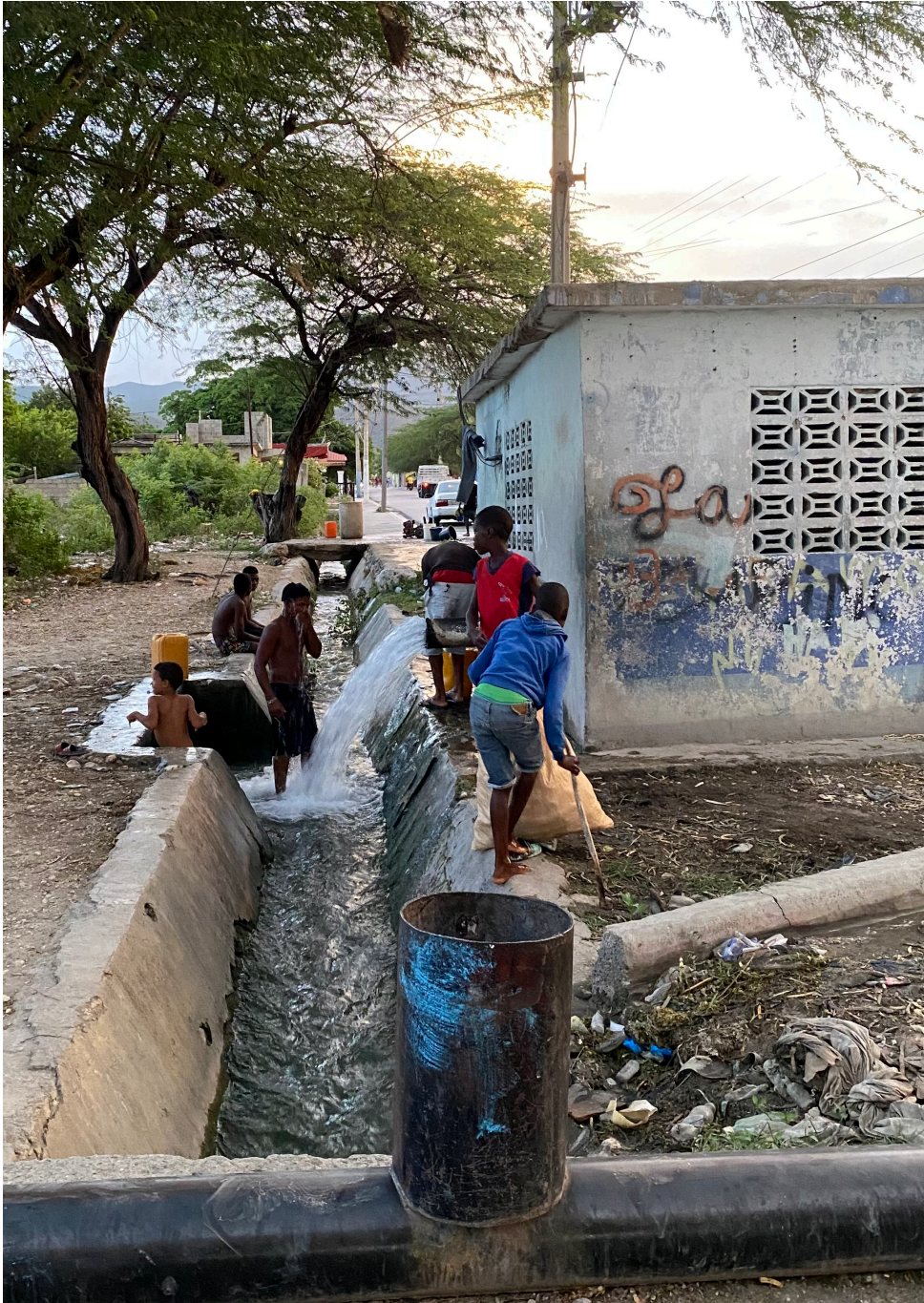
Este canal se abastece de agua del Río Blanco. El canal es utilizado en ese sector para la agricultura y consumo humano. La caseta es un punto de control de INAPA en donde está localizada la bomba distribuidora. Nótese la cantidad de desecho en este punto.
