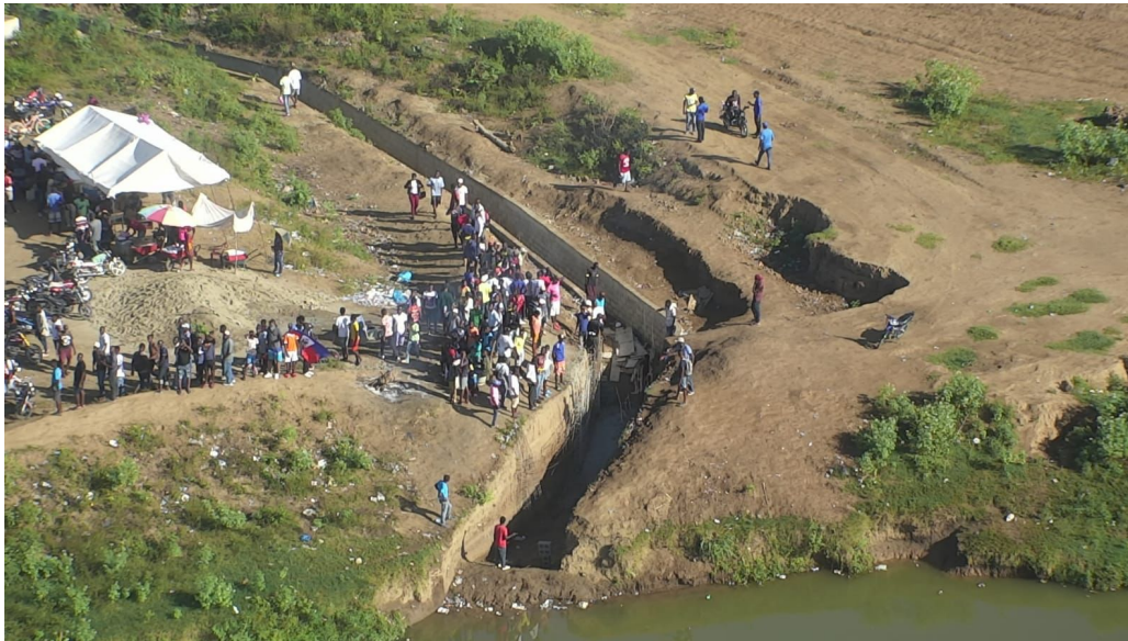
Foto CESFront. Vista de los avances de la construcción del canal en Ounaminthe en fecha 11 de septiembre del 2023. Esta construcción ha sido objetada fuertemente por el gobierno dominicano, situación que ha resultado en el cierre de la frontera dominico-haitiana hasta tanto se llegue a una solución. La construcción de una obra de esta naturaleza afectaría a las comunidades La Vigía, Sánchez, Cañongo, Laguna de Saladilla, Carbonera y Manzanillo. La construcción de este canal viola el Tratado de Paz y Amistad Perpetua y Arbitraje firmado en 1929.
