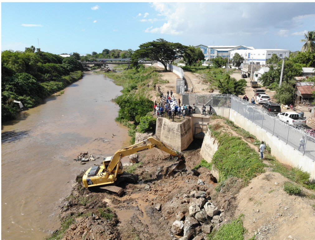
Rehabilitación de la toma de agua de La Vigía o La Aduana. Esta obra fue autorizada por el gobierno dominicano en respuesta a la construcción del canal en las llanuras de Maribaroux.
