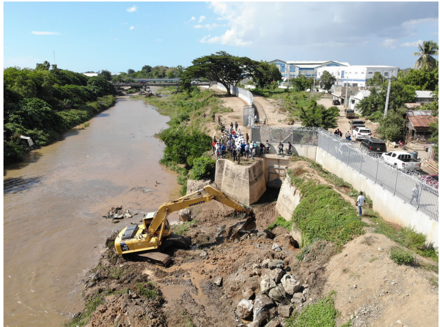
Rehabilitación de la toma de agua de La Vigía o La Aduana. Esta obra fue autorizada por el gobierno dominicano en respuesta a la construcción del canal en las llanuras de Maribaroux.
