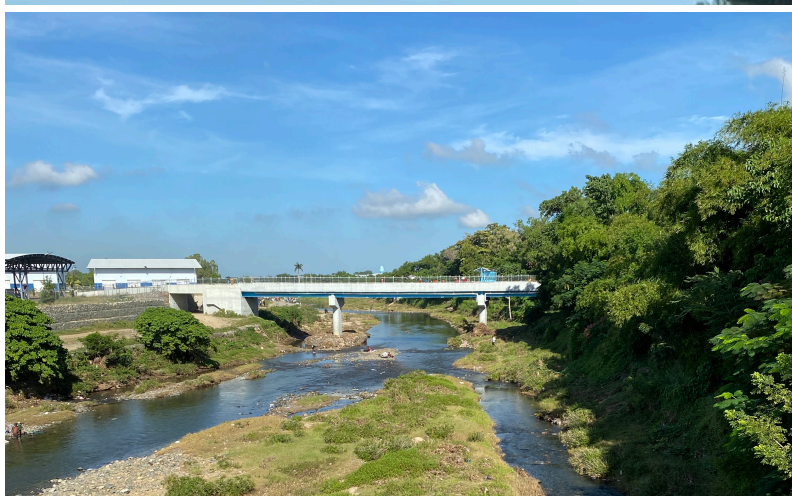
Puente que conecta las dos "Puertas" que unen los mercados Dajabón y Ounaminthe. Cientos de ciudadanos haitianos se aglomeran en este puente desde horas de la madrugada. Este puente es nuevo. Un puente que existía antes del 2017 colapsó por las fuertes lluvias del huracán Irma.
