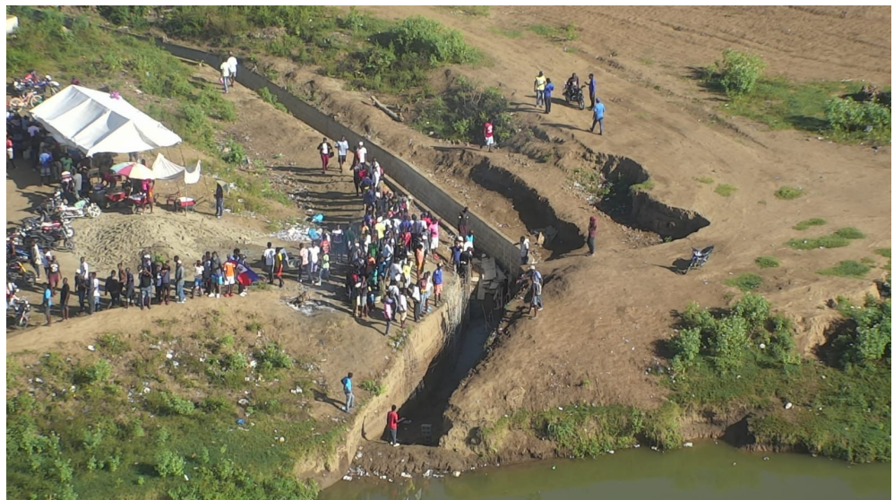
Foto CESFront. Vista de los avances de la construcción del canal en Ounaminthe en fecha 11 de septiembre del 2023. Esta construcción ha sido objetada fuertemente por el gobierno dominicano, situación que ha resultado en el cierre de la frontera dominico-haitiana hasta tanto se llegue a una solución. La construcción de una obra de esta naturaleza afectaría a las comunidades La Vigía, Sánchez, Cañongo, Laguna de Saladilla, Carbonera y Manzanillo. La construcción de este canal viola el Tratado de Paz y Amistad Perpetua y Arbitraje firmado en 1929.
