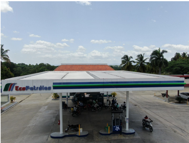
Estación combustible A.B.B. ubicada en la entrada a Comendador, Carretera Sánchez.
