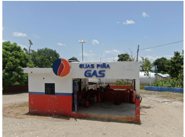
Estación Elías Piña Gas ubicada en la Carretera Sánchez, zona comercial Carrizal.
