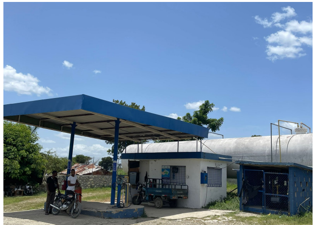
Estación de gas propano Rafa Gas, ubicada en el sector de Villa Hortencia.
